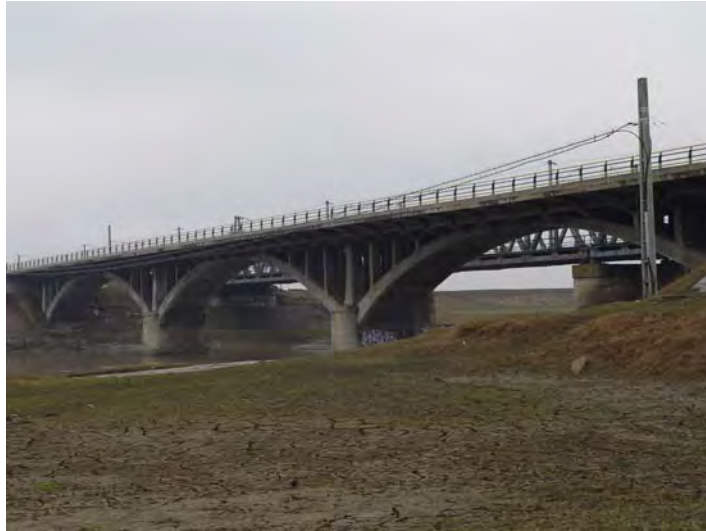
Fig. 1.1. Bridge on NR 28A, km 22+660 .
